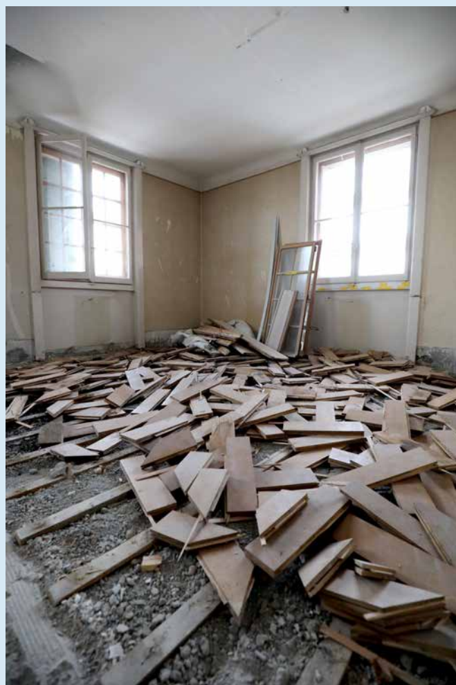
Démontage des parquets en chêne et châtaignier massif
