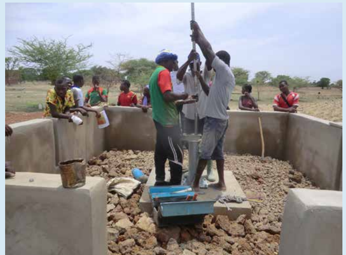
Installation de la pompe du forage
