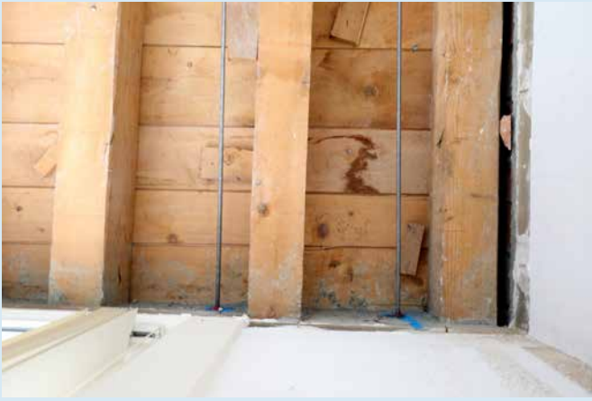
Renforcement sismique, solidarisation des façades
