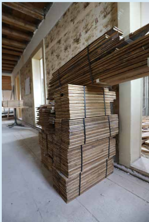
Stockage des parquets pour repose après travaux de chapes
