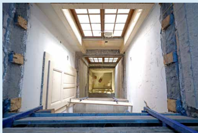
Création de la cage d'ascenseur
