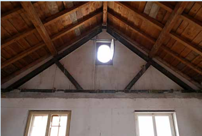
Renforcement sismique du fronton du bâtiment
