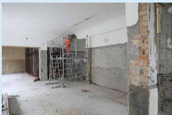
Début des travaux de démolition
