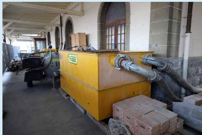
Installation de pompage pour l'abaissement de la nappe phréatique
