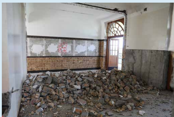
Ouverture des murs pour la création de la salle du rez-de-chaussée
