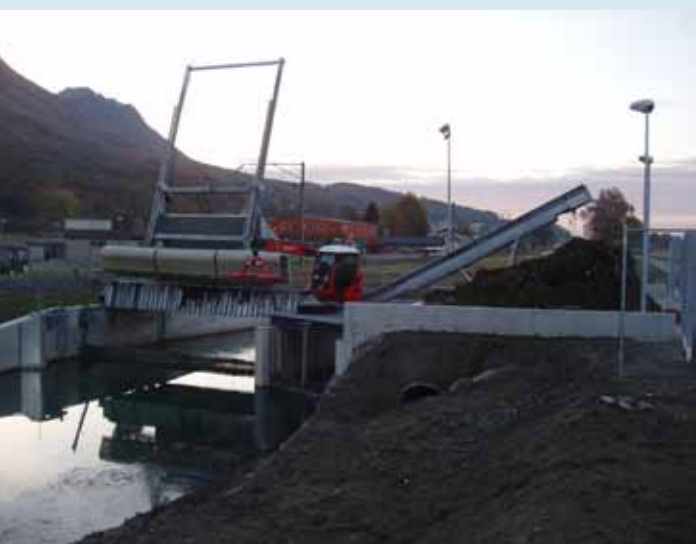
dégrilleur en cours de construction
